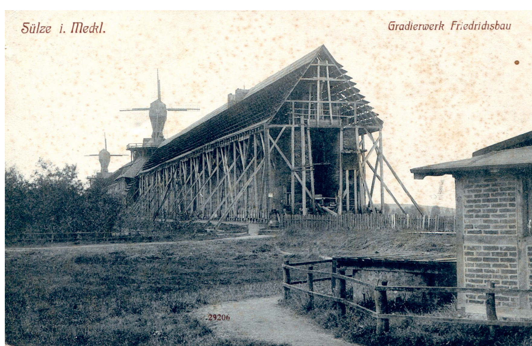
Die Ruine des Gradierwerkes „Friedrichsbau“ gibt den beiden Museumsgründern Schwung: Sie haben täglich den Verfall dieses letzten und größten Sülzer Gradierwerkes im Kurpark vor Augen. In wenigen Jahren würde nichts mehr in Bad Sülze an die Blütezeit der Großherzoglichen Saline erinnern. Anfang der 1970er Jahre werden die Reste des „Friedrichsbaus“ von der Baubrigade der hiesigen LPG abgerissen. Postkarte 1909.
