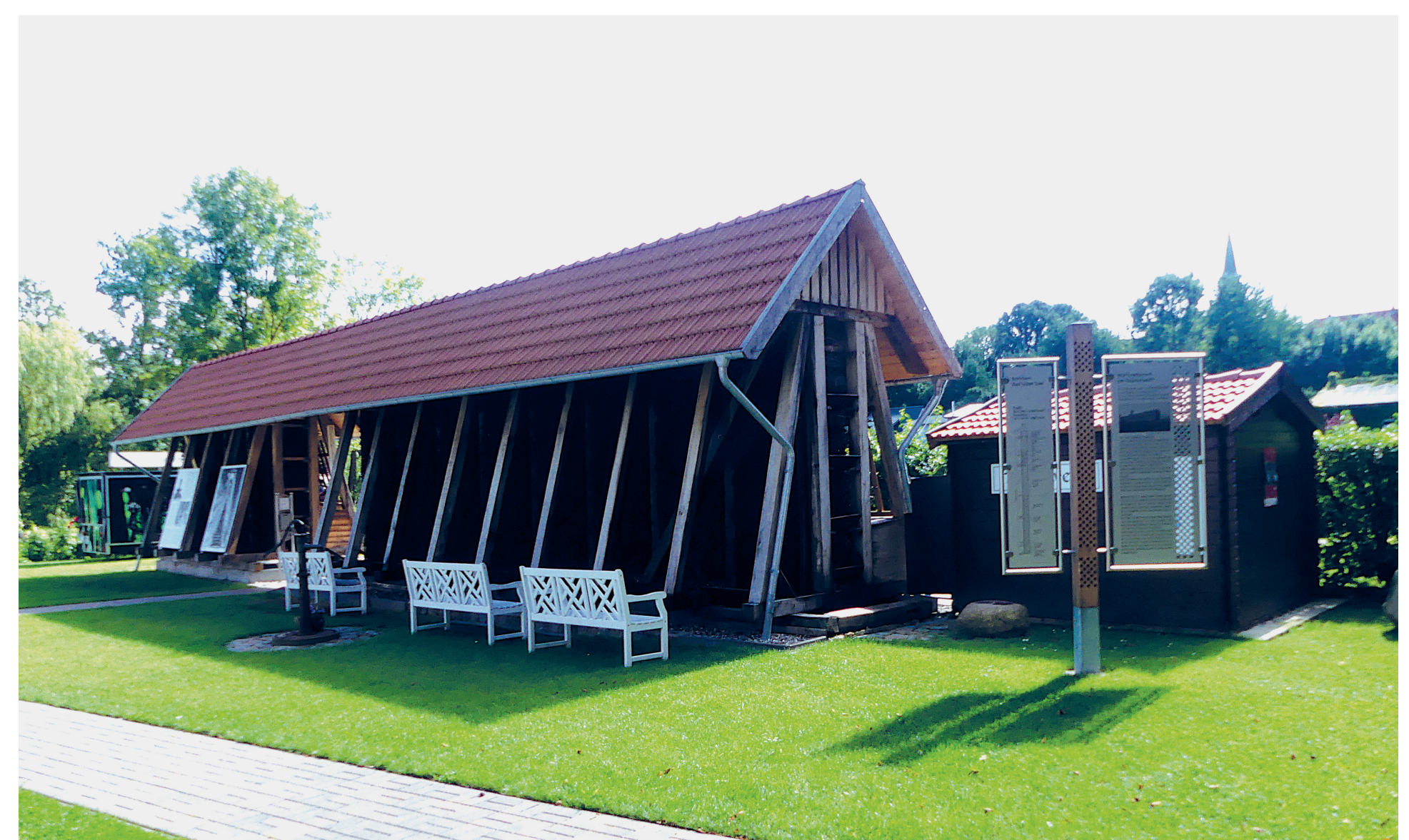
2020: Ein neues Gradierwerk mit Pumpenanlage im Museumsgarten. Täglich atmen die Besucher die gesunde Sole. Sie wird aus 30 m Tiefe hochgepumpt und auf dem Gradierwerk – durch stetes Verrieseln – konzentriert.
